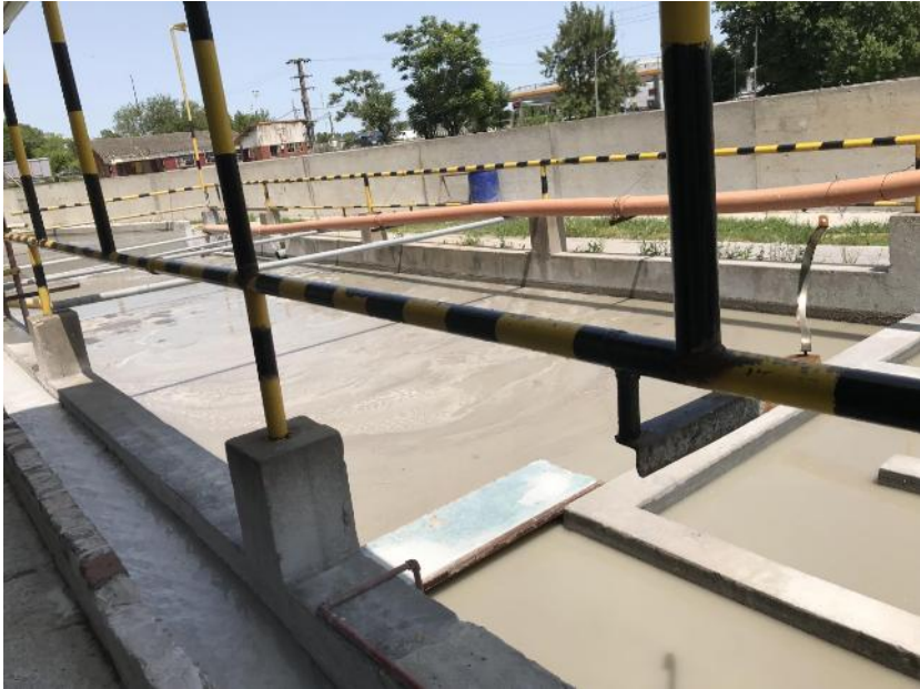
Figura 27. Pileta de efluentes que vuelvan sobre el arroyo El Gato. Fotografía propia.
