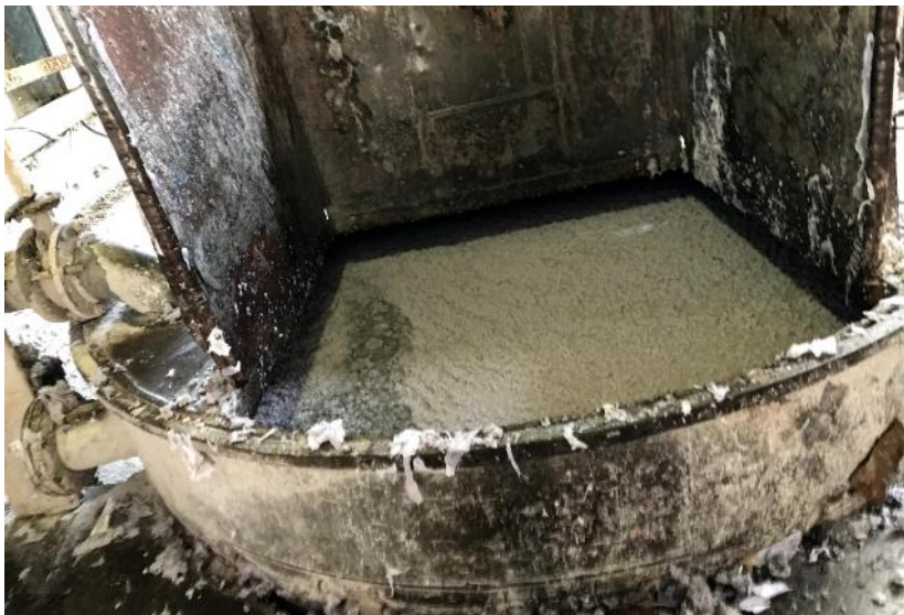
Figura 8. Pulper vacío donde se cargan insumos para papel higiénico. Fotografía propia.
